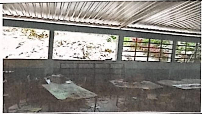
Foto 4: Instalacion de ventanas del establecimiento.
