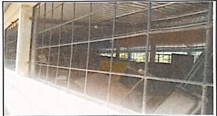
Foto 4: colocacion de vidrios a ventanales
