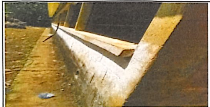
Foto 5: pintura de aulas y corredor
