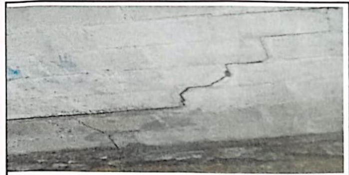
Foto 6: reparación de muros de contencion
