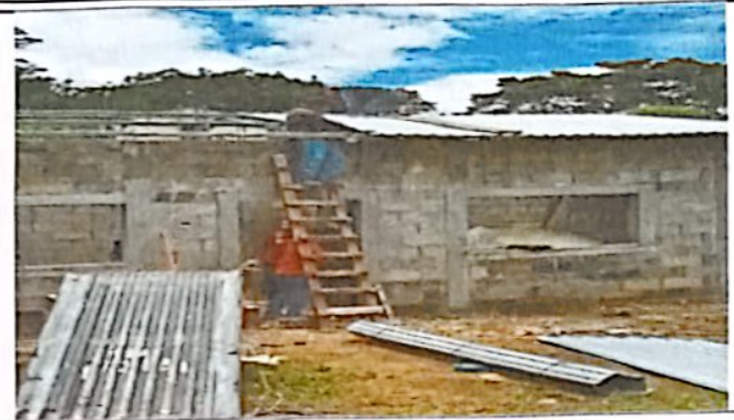
Foto 2: Reparación de pared y entechado de la cocina.
