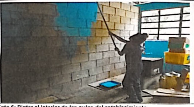
Foto 6: Pintar el interior de las aulas del establecimiento.
