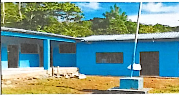
Foto 1: Reconstrucción de cocina Escolar.
